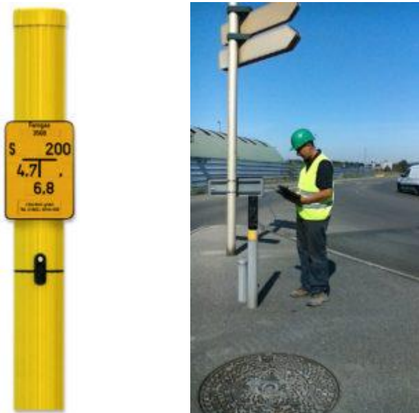
Figure 5 Contrôle et maintenance de protection cathodique Ailematic
