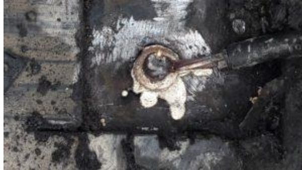
Figure 11 Soudure thermoweld aluminothermique Ailematic
